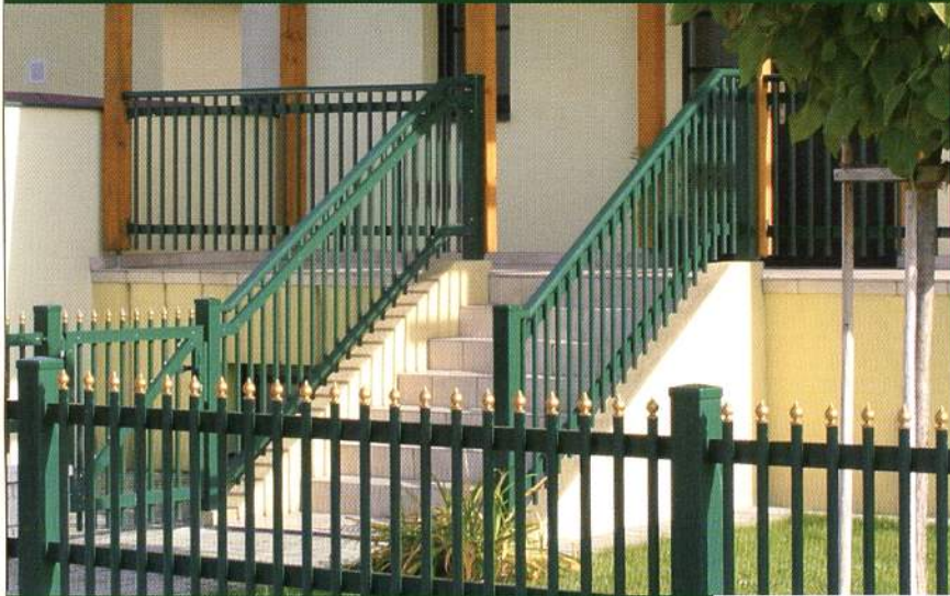
Bild 5-3201: Geländer mit Handlauf, in RAL 6005
